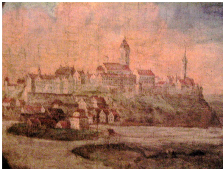
© Hofkirche Neuburg/Do - Foto vom Verfasser Abb. 55:
